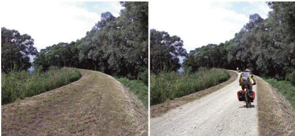
Ryc. 76 Przykładowa dostosowanie wału przeciwpowodziowego - utwardzenie kruszywem
