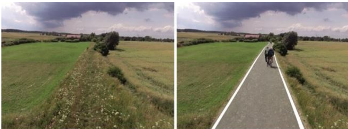
Ryc. 79 Przykładowa dostosowanie nieczynnej linii kolejowej - nawierzchnia bitumiczna
